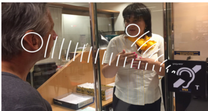
Obr. 22: Trvale zabudovaná přepážková IL na poště a obr. 23: Přenosná IL
