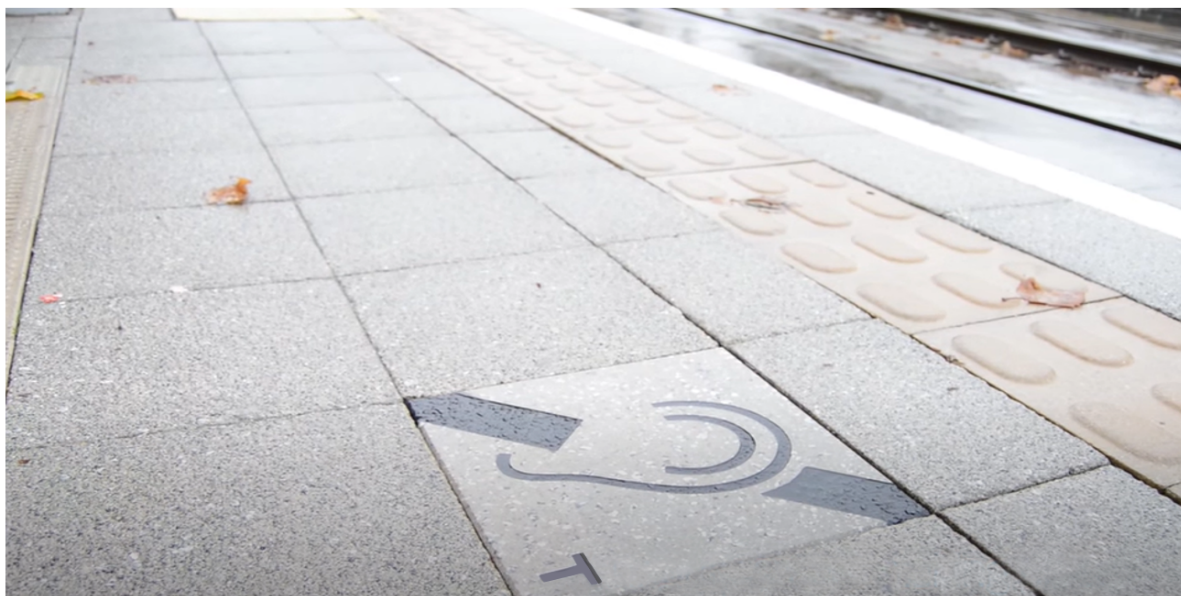
Obr. 14: Označení instalované IL smyčky na ploše nástupiště formou betonové kachličky v Nottinghamu
